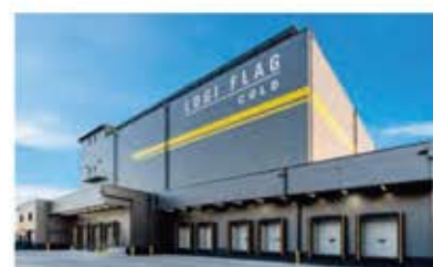
Cold Logi 船橋
